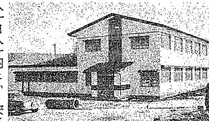
完成した二中の寄宿舎
